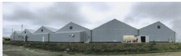
ISPS エビ養殖プラント (静岡県磐田市：年生産量 80トン)
